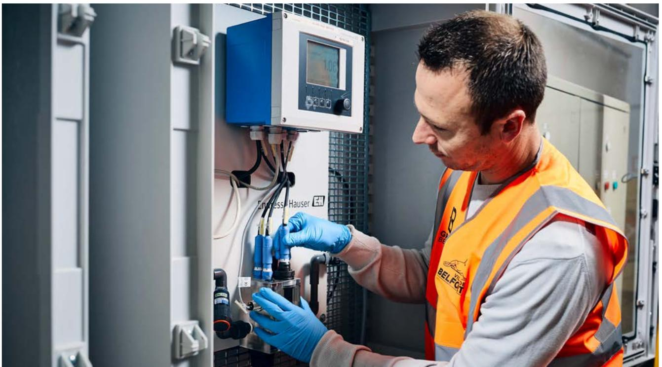
Mit unseren Messumformern und Sensoren können Sie Ihr Roh- und Reinwasser sicher überwachen. Viele Wasserwerke bestellen die Messtechnik vormontiert auf Messtafeln (Panels). Dadurch lassen sich die Messstellen einfach an einem Ort installieren, betreiben und instand halten.
