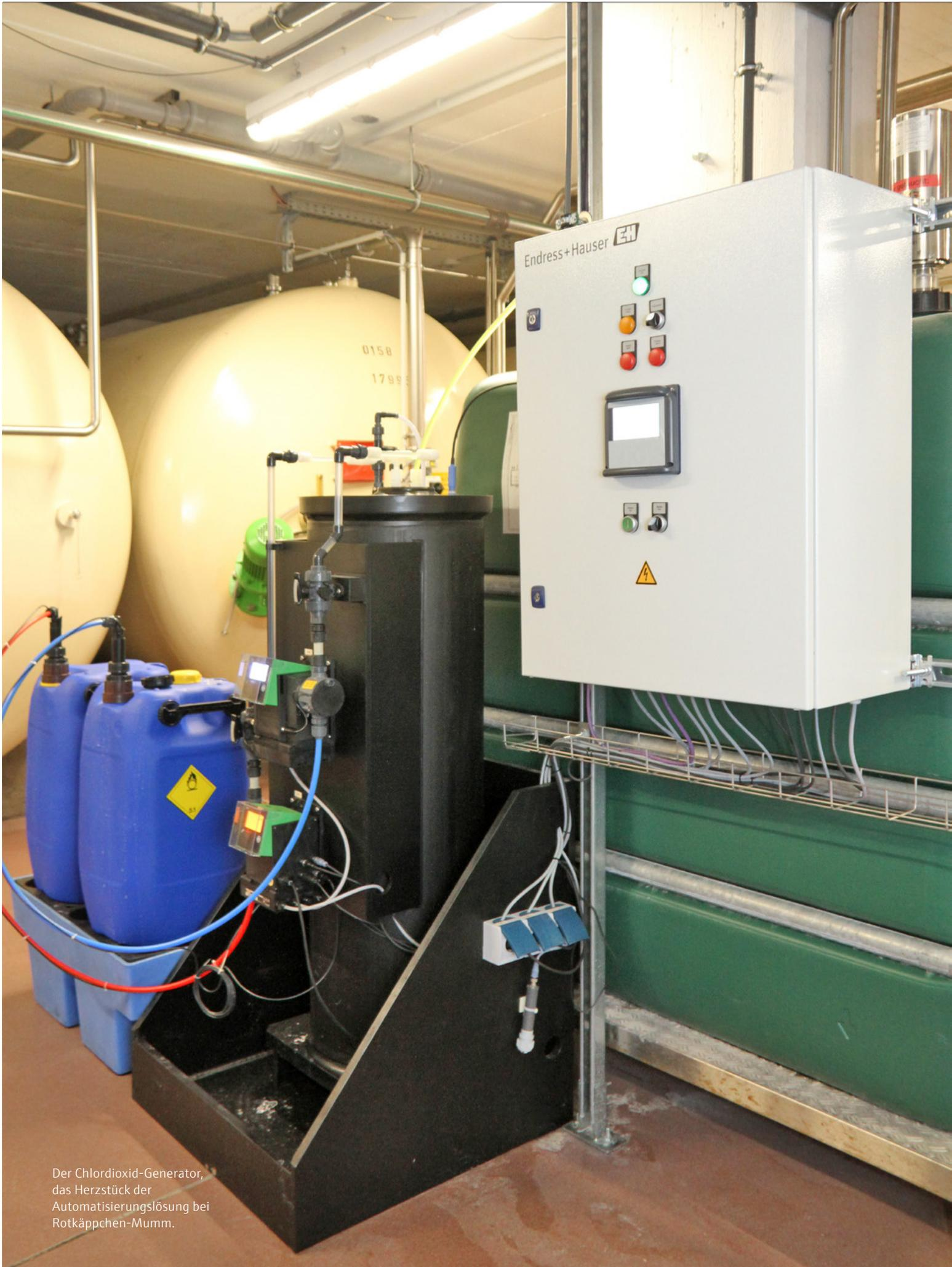
Der Chlordioxid-Generator, das Herzstück der Automatisierungslösung bei Rotkäppchen-Mumm.
