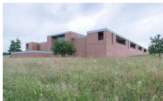
Das Seewasserwerk Frasnacht am Bodensee
