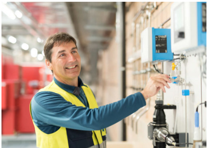
Sehr zufrieden mit den Analysepanels: Rolf Bügler, Wasserwart im Seewasserwerk Frasnacht.
