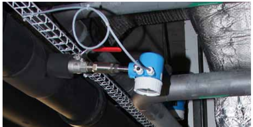
Geringe Gerätekosten, einfache Installation und Inbetriebnahme: t-mass T 150 im Einsatz.
