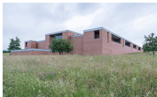
La station d'épuration de Frasnacht sur le Lac de Constance
